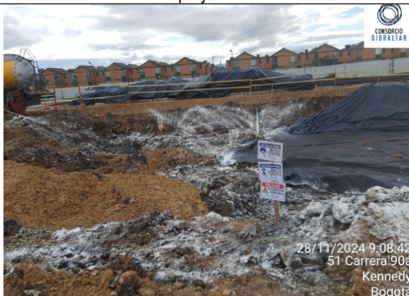
Fotografía No. 11: Excavación con relleno antrópico neutralizada con cal
