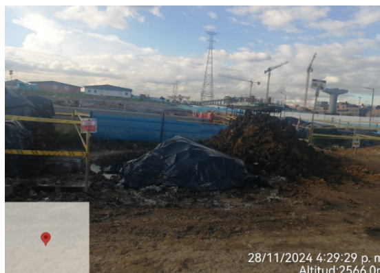
Fotografía No. 12: Material de relleno antrópico neutralizado con cal y cubierto
