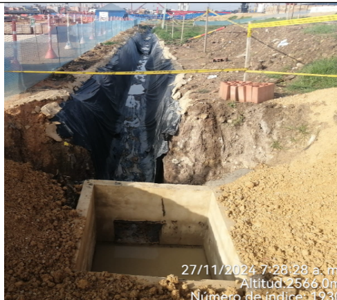
Fotografía No. 10: Entrada de canales a cajas de achique desarenadoras
