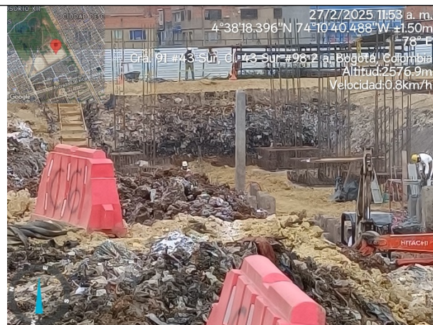
Fotografía No. 4: Perfiles de la excavación con residuos enterrados
